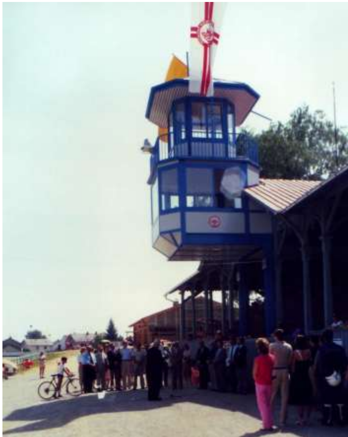
Der neue Zielrichterturm erstrahlt in neuem Glanz und vor allem am richtigen Ort. Mit 150 000 DM hat der RSC zur Finanzierung maßgeblich beigetragen.
