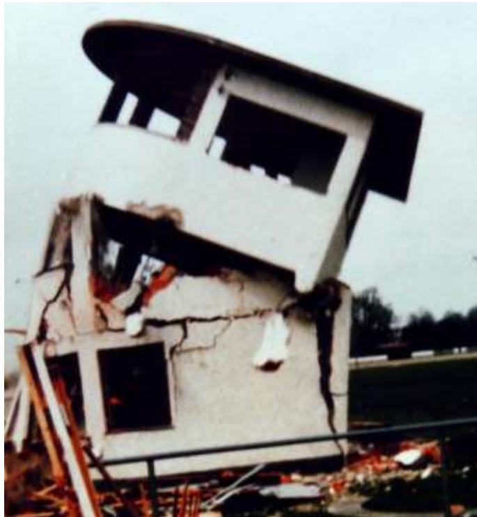
Der Richterturm in der Innenbahn war bei den Sandbahnrennen ein Gefahrelement, das entfernt werden musste.
